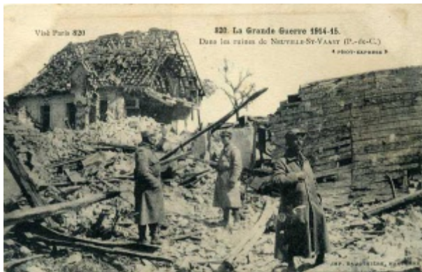
Dans les ruines de Neuville St Vaast_Pas de Calais
