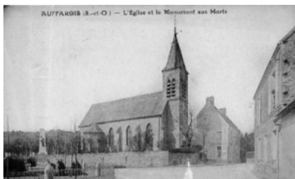
Monument aux morts et église d'Auffargis
