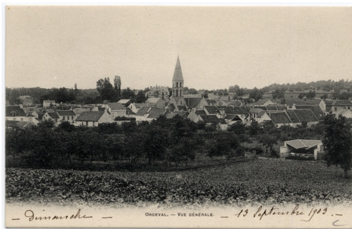
Orgeval - Vue générale, ADY 3Fi182 16
