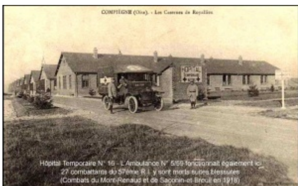
Hôpital temporaire de la caserne de Royallieu
